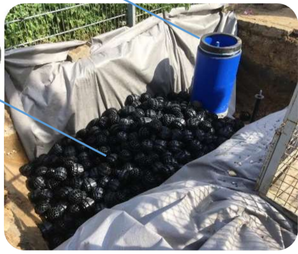
BEAULEX - 100% Recyclingmaterial Versickerungs-Hohlkugeln 930l/m 3
