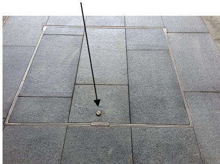
3. Akkuschrauber mit Inbus 6mm, auf Innensechskantschraube im Rohr stecken und Schachtabdeckung mit Hilfe der Bohrmaschine im Uhrzeigersinn drehend öffnen.
