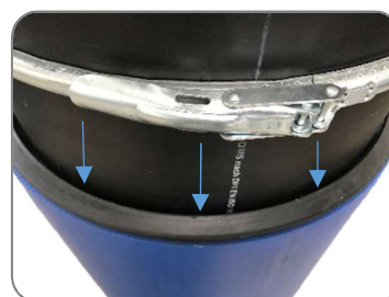
Wasser an die Dichtung aufbringen zur leichteren Verstellung des Schutzmantels
