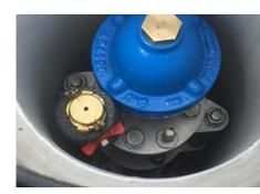
Blick zum Be- und Entlüftungsventil, der Spül- u. Entnahmeeinheit und Innengarnitur mit Hauptabsperrung
