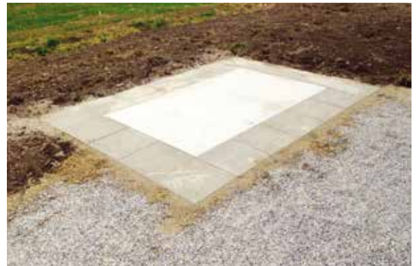
Fertiggestellte Anschlussflächen zur REVI+ Schachtabdeckung
