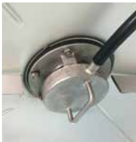
Die P-FIX Filtereinheit – eingebaut im Lüftungsrohr der Schachtabdeckung für Quellschächte und Trinkwasserbrunnen mit Ableitungsrohrleitung
