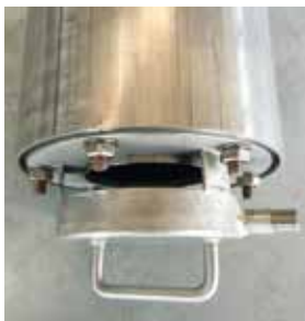
Die P-FIX Filtereinheit – eingebaut im Be- und Entlüftungsrohr
