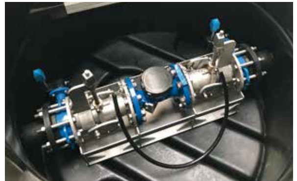
VARIO-FIX-Einheit als Spül- und Messeinheit
