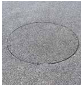
Schachtabdeckung asphaltiert rund
