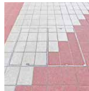
Schachtabdeckung ausgeplastert mehrteilig
