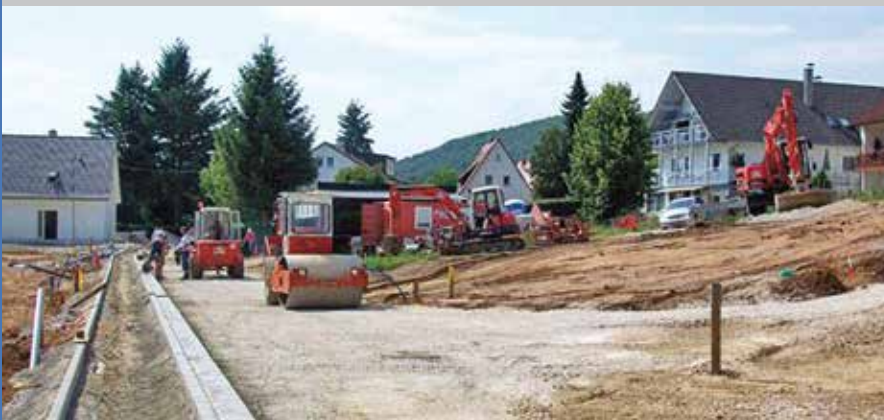
Umsetzung und Durchführung von Infrastrukturmaßnahmen.
