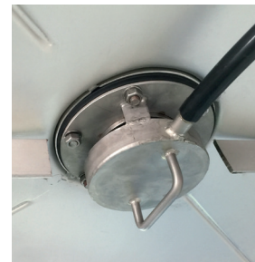
Die P-FIX Filtereinheit – eingebaut im Lüftungsrohr der Schachtabdeckung für Quellschächte und Trinkwasserbrunnen mit Ableitungsrohrleitung
