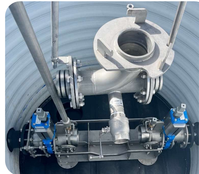
FLEXClean System - Spül- und Molch-Y-Stück mit FLEX-DREH-Flansch entnehmen
