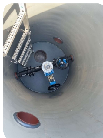
KOMPACT SCHACHT, Wasserzähler-Schacht – DROSSEL-Schacht mit Elektroantrieb – KOMPACT Verteiler-Schacht – Druckminderer-Schacht – KOMPACT Löschwasser-Revisions-Schacht
