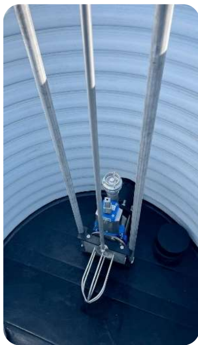
KOMPACT SCHACHT, FLEXClean – Spül-Molch-WZ-Be- u. Entlüftungsstation und Molch-Spül-Druckendschacht mit Drucküberwachungsmöglichkeit
