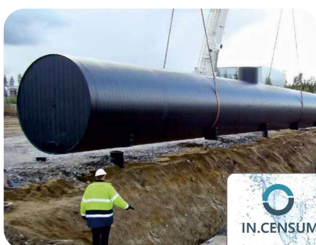
ARMARE-TEC VAULT – REGENWASSER-Sedimentationsanlage u. Patronen-FILTER-ANLAGEN – auch mit Sensorik überwacht - Schlammhöhenmessung
