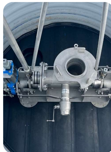
FLEXClean System - Spül- und Molch-Y-Stück mit FLEX-DREH-Flansch entnehmen
