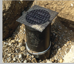
Einbau des TELE Unterflurhydranten NT
