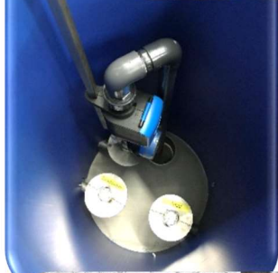
Spülsystem 72plus Im AMPER-Spül-WZ-Schacht Die WZ-Einheit ist an der Edelstahl-KLICK-Einheit einzustecken.
